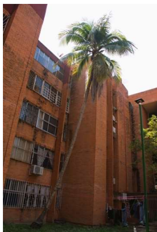
Fig. 6. Árboles inclinados y con riesgo de caer con mayor facilidad debido a la incorrecta ubicación.
